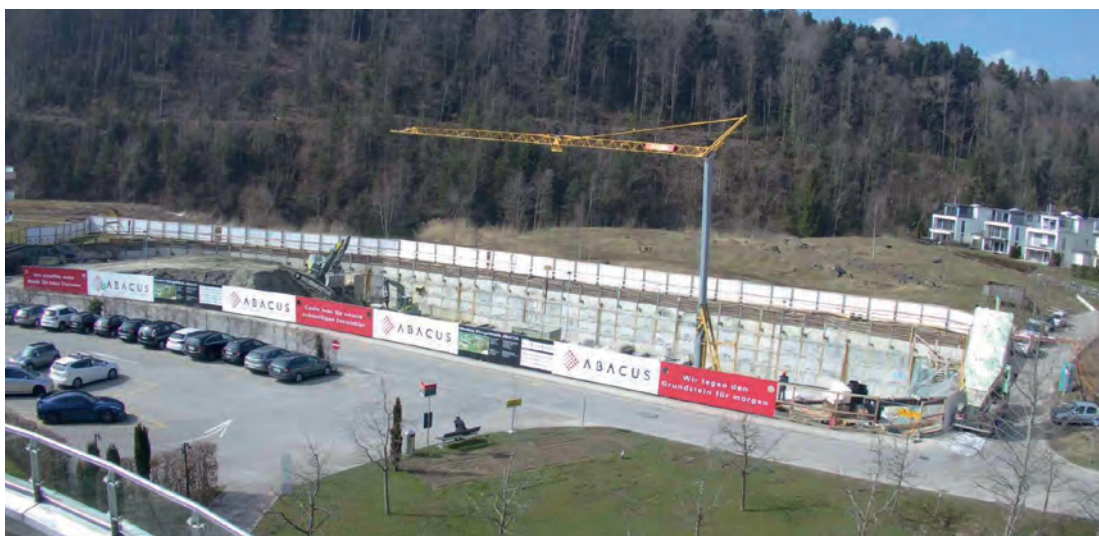
Baustelle des ABACUS Erweiterungsbau im März 2016
